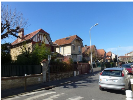
Ensemble homogène du lotissement de la Ferme, avenue de la République
