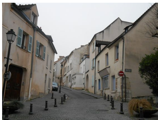
Rue de Saint-Germain : une cohérence architecturale, tant dans les gabarits que dans la forme architecturale, à préserver
