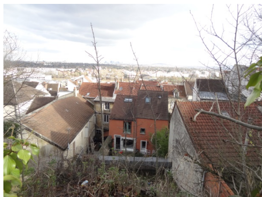
10-12bis rue de Saint-Germain vus depuis l'avenue de Lattre de Tassigny : le front bâti continu cache des jardins intérieurs
