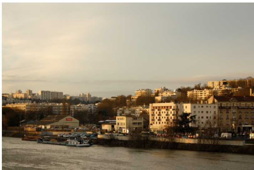
Les immeubles collectifs structurent la lecture du grand paysage et constituent autant de signaux aux différents échelles
